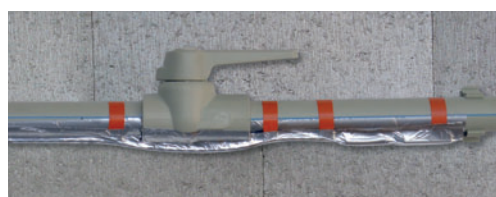
přelepení topného kabelu hliníkovou páskou
